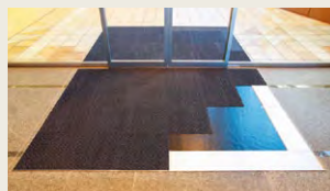
③タイルマットをはめ込んでいきます。
