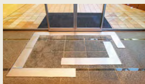
①フレームユニットを設置。
